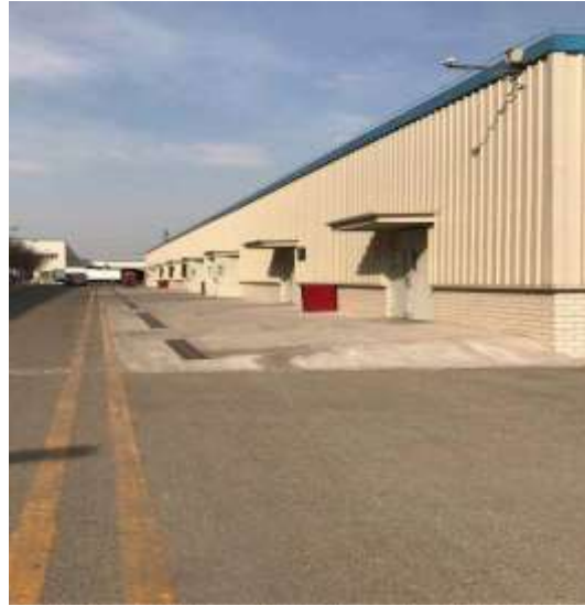
危险废物暂存区
